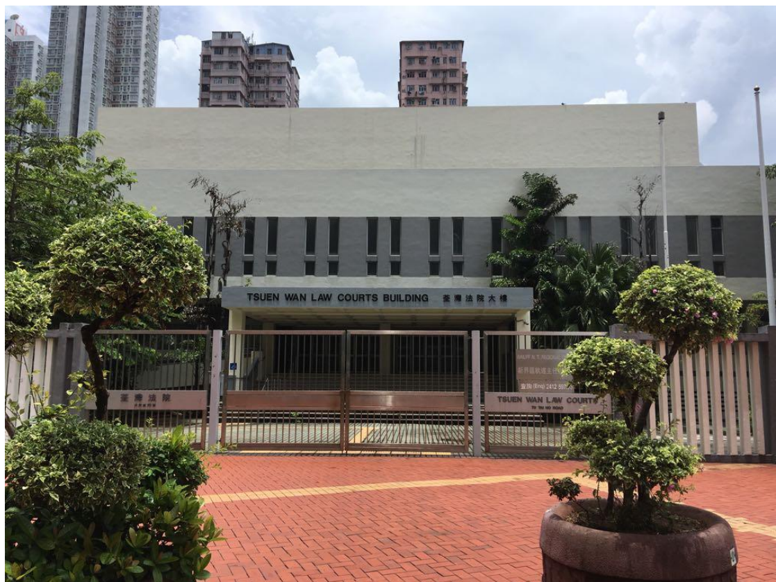
前荃湾法院大楼正门的相片
